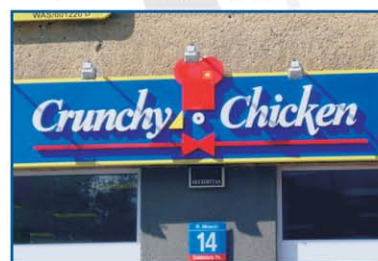
Otok winylowy z logotypem; litery brytowe ze styroduru montowane na dystansie; podświetlenie zewnętrzne - halogeny na wysięgnikach.
