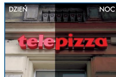
Litery bryłowe podświetlone od wewnątrz diodami LED, świecące do przodu.
