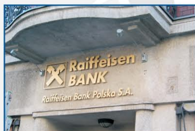
Wykończone dibondem lico liter brylowych.
