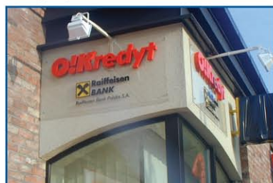
Litery bryłowe ze styroduru naklejone na panel z bezbarwnej pleksi.
