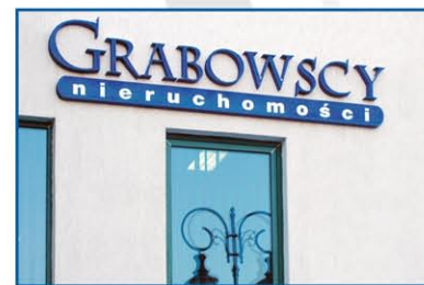
Litery bryłowe ze styroduru, lico wykonane z pleksi.
