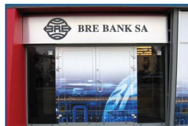
Litery przestrzenne z pleksi zamontowane w kasetonie z dibondu, podświetlone od wewnątrz diodami (LED), lico liter wyklejone folią translucyentną.
