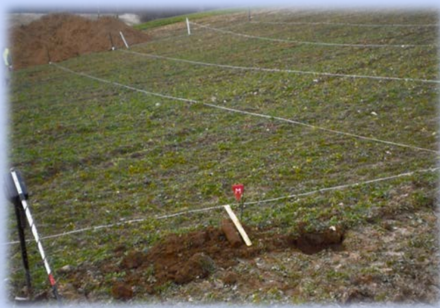
Wytyczanie geodezyjne terenu prac, podział i oznakowanie poszczególnych odcinków
