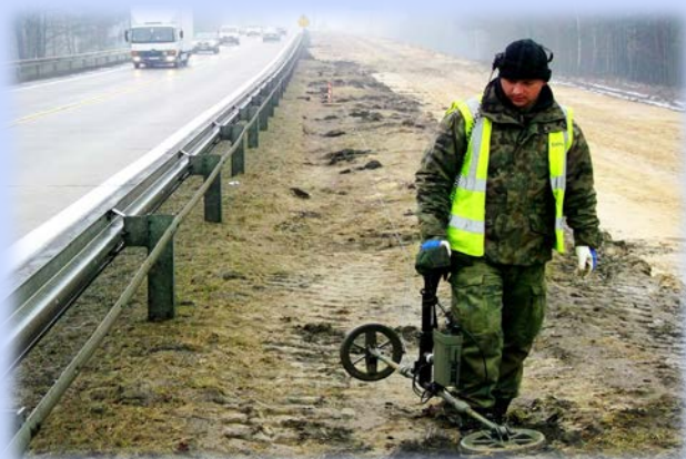
Prace saperskie na budowie autostrady przy użyciu dwucewkowego wykrywacza metali oraz wykrywacza ramowego
