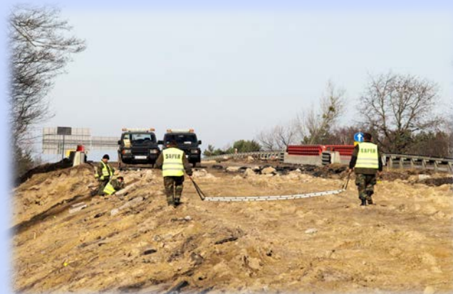
Prace saperskie na budowie autostrady przy użyciu dwucewkowego wykrywacza metali oraz wykrywacza ramowego
