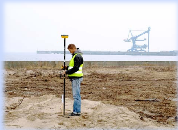
Wytyczanie geodezyjne terenu prac, podział i oznakowanie poszczególnych odcinków
