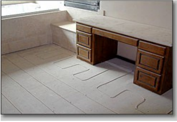
Kabel grzewczy łatwo układa się do kształtu podłogi łazienki
