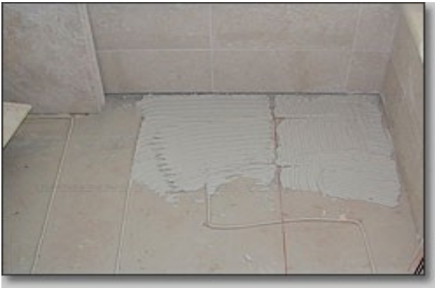
Warstwa kleju o grubości 1,5 cm
