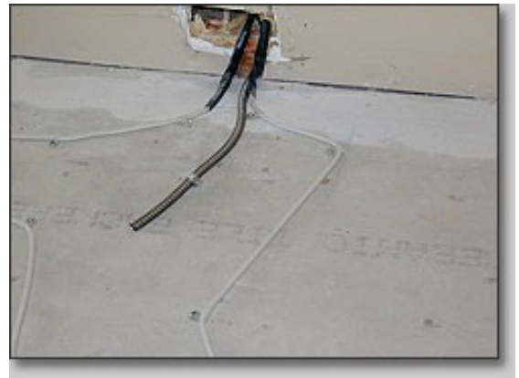
Ustaw czujnik temperatury
