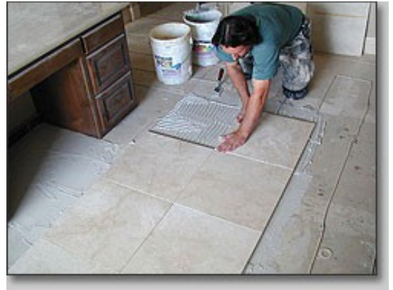
Montaż płytek na kleju
