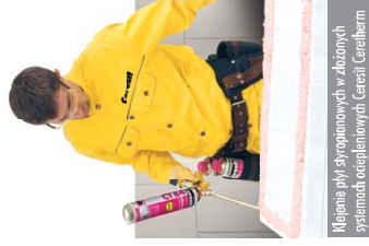
Uzupelnianie szczelin pomiędzy płytami styropianowymi
