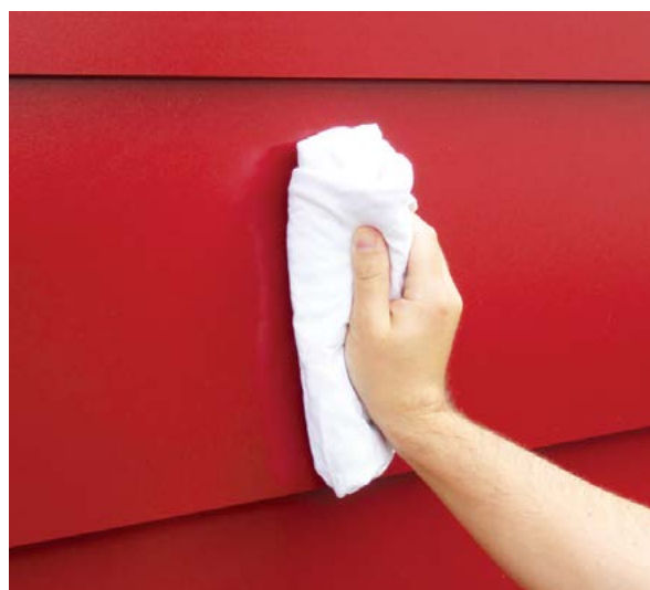
Rys. Czyszczenie paneli Krono Siding.
