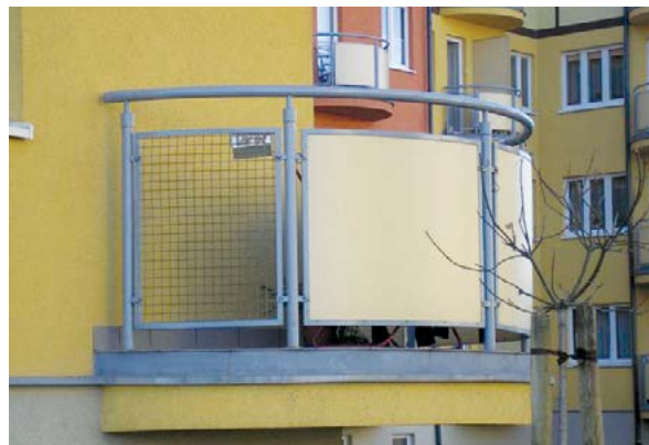
Rys. Montaż płyt balkonowych.
