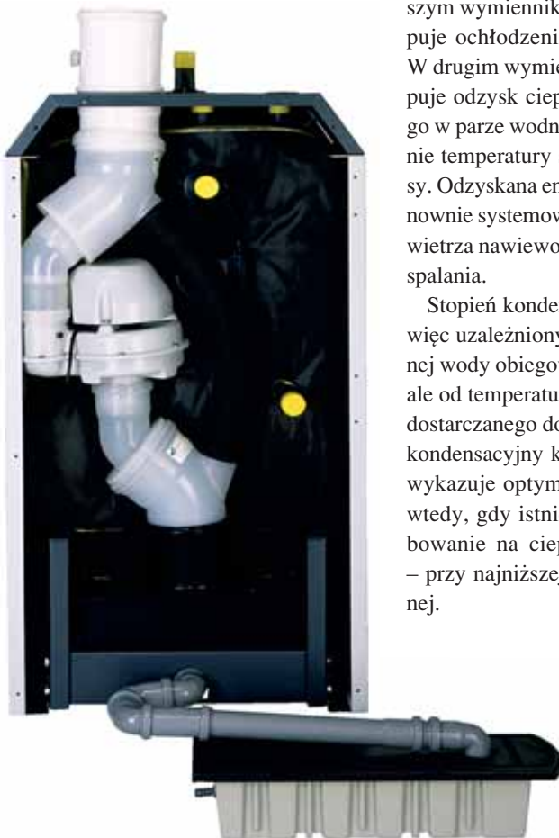
Tylna część kotła z izolacją i pojemnikiem wypełnionym granulem uwodnionego tlenku magnezu – do neutralizacji kondensatu
