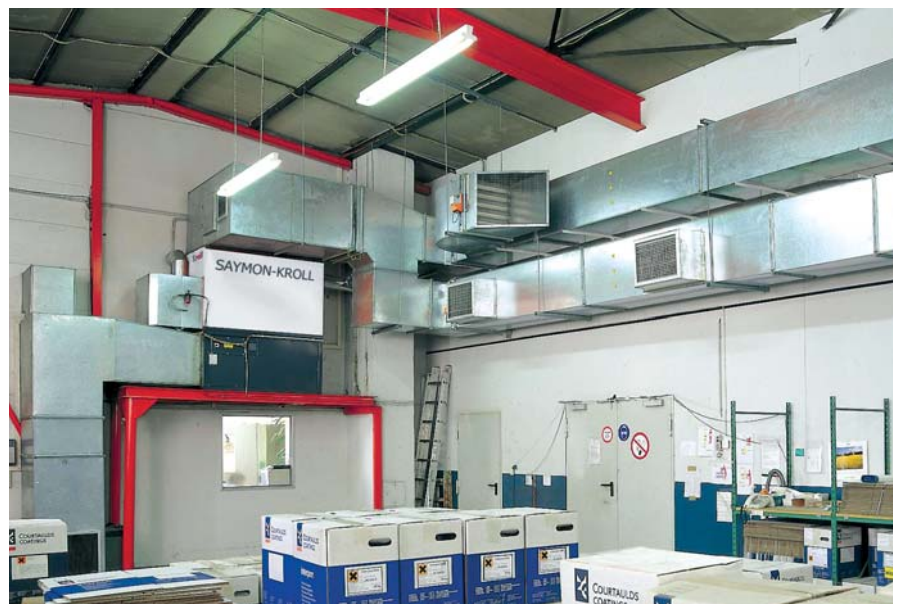
Rys. 4. Przykład zastosowania stacjonarnego urządzenia grzewczo-wentylacyjnego firmy Saymon w układzie ogrzewania kanalowego
