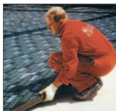
Przykład ogrzewanej podłogi izolowanej płytami FOAMGLAS® BOARD
