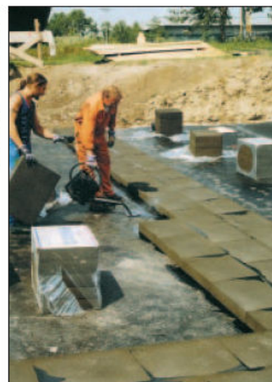
Wariant izolacji podłogi przy pomocy płyt FOAMGLAS®
