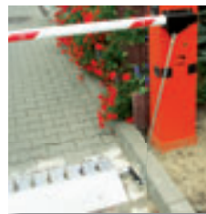
Mechaniczne połączenie kolczatki ze szlabanem.
