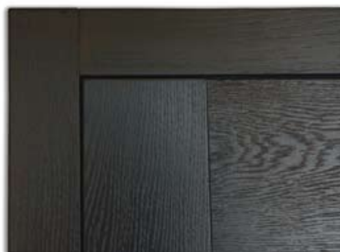
Łączenie opasek pod kątem 90°
