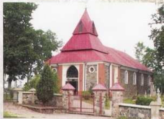
Kościół p.w. Św. Rocha w Krasnymborze
