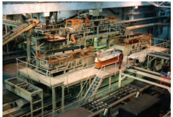
Linia produkcyjna (instalacja dozowania składników)
