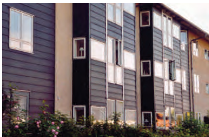
Holandia: częściowe pokrycie fasady przy użyciu paneli AMROC Color Finish
