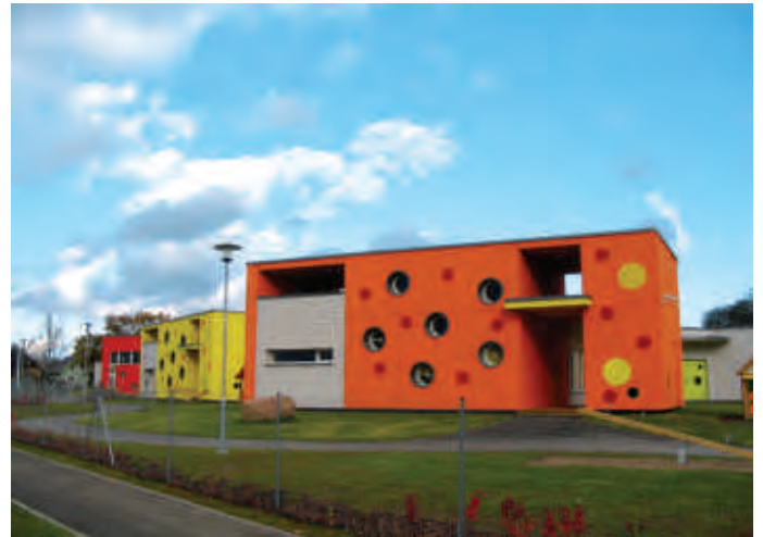
Przedszkole pokryte płytami AMROC Granit
