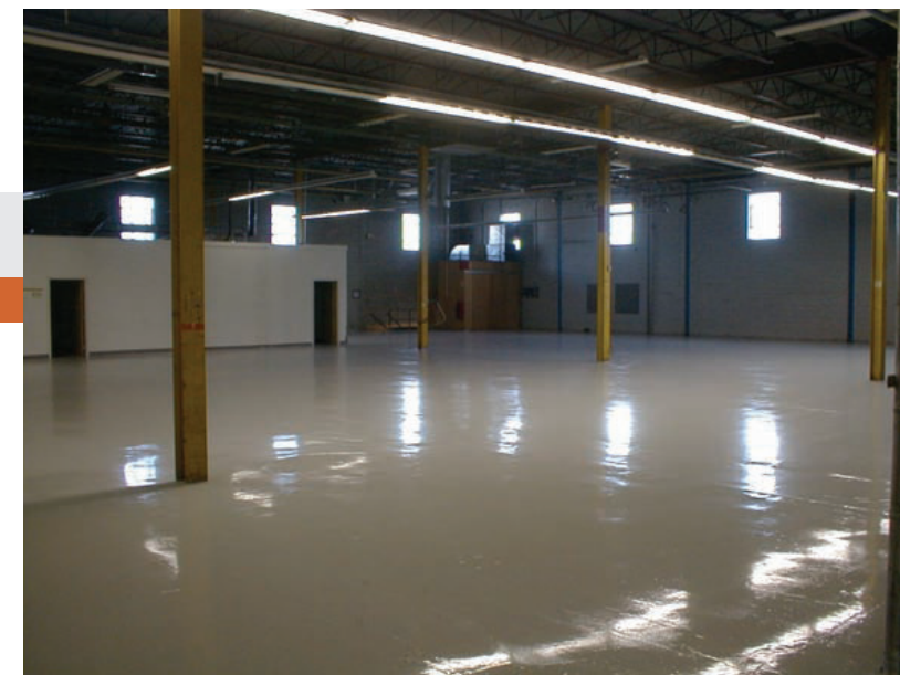
Podłoga w hali produkcyjnej
