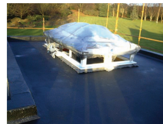
Dach hali przemysłowej
