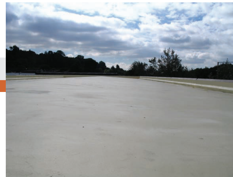
Dach płaski budynku wielorodzinnego
