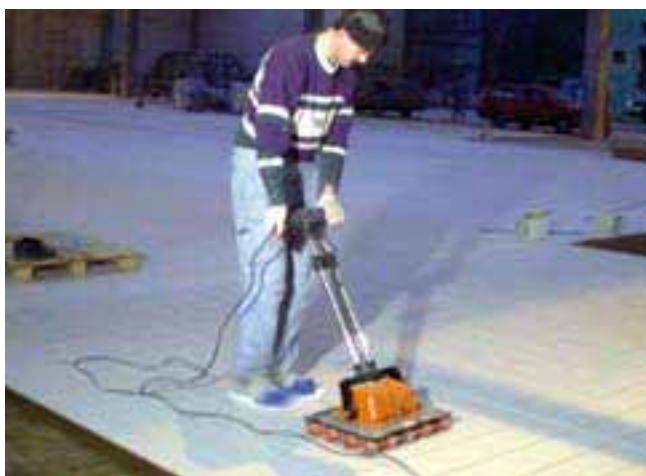
Wibrowanie świeżo ułożonej okładziny ceramicznej.
