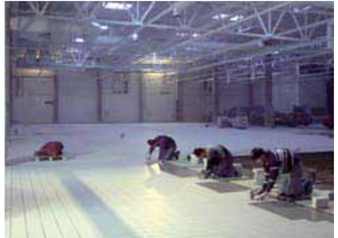
Układanie okładziny ceramicznej na świeżej warstwie zaprawy kontaktowej.
