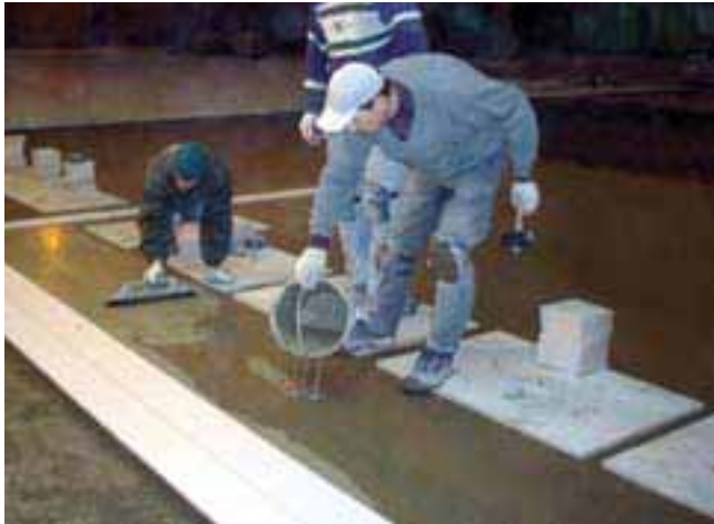
Nanoszenie zaprawy kontaktowej na przygotowaną warstwę zaprawy.
